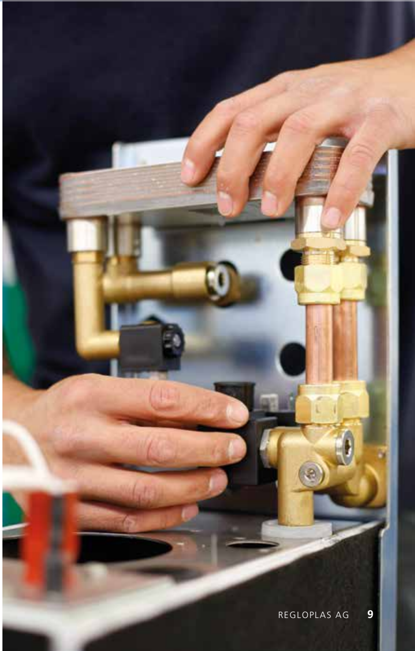
Bachofen-Magnetventilblock für Vor- und Rücklauf aus Messing-Warmpressteil
