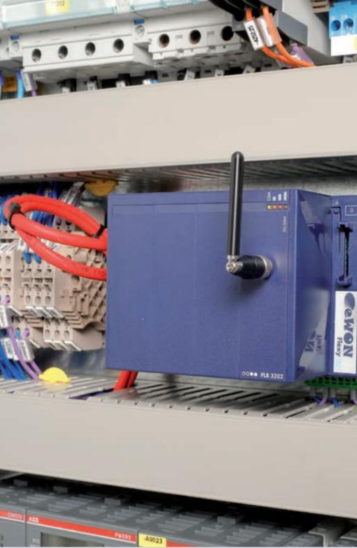
Im Schaltschrank eingebautes **Bachofen eWON Flexy** mit 3G-Modem
