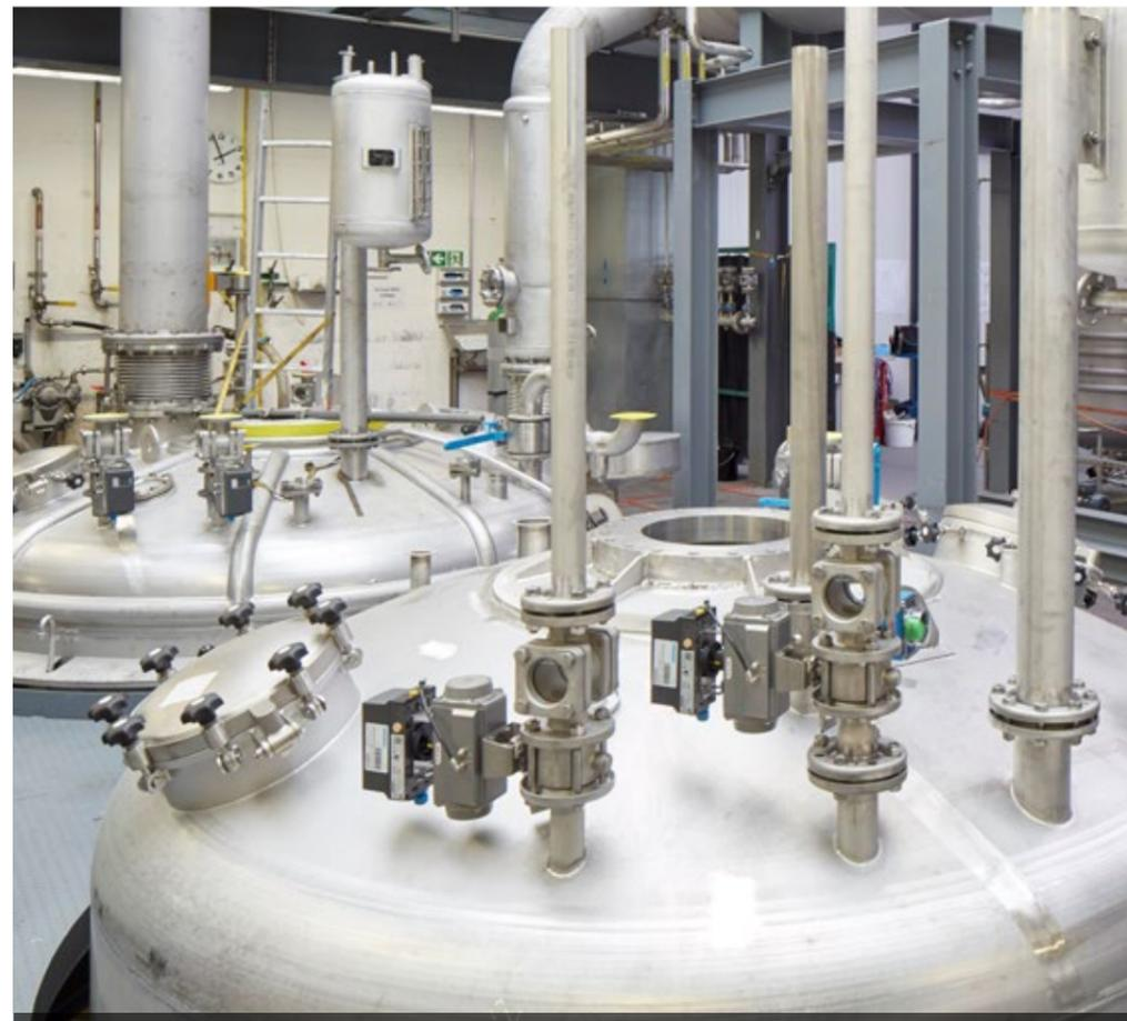
Zwei Reaktoren für die Klebstoff-Polymerisierung im Aufbau, an den Zuleitungen sind die Regelarmaturen (Kugelsektorventile) bereits montiert.
