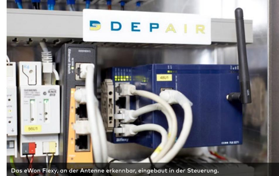
Das eWON Flexy, an der Antenne erkennbar, eingebaut in der Steuerung.
