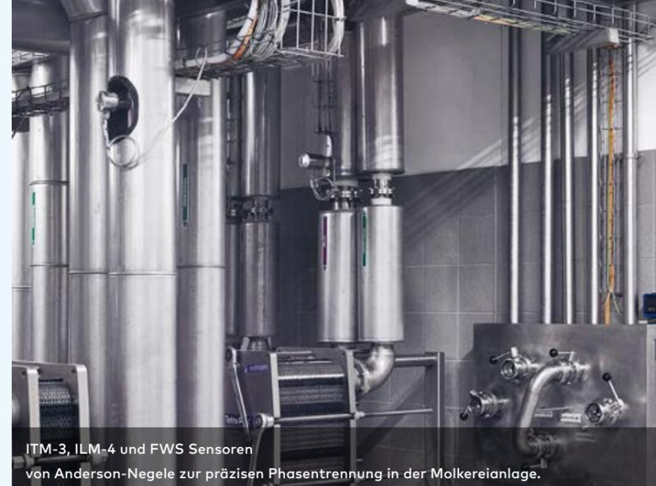
ITM-3, ILM-4 und FWS Sensoren von Anderson-Negele zur präzisen Phasentrennung in der Molkereianlage.
