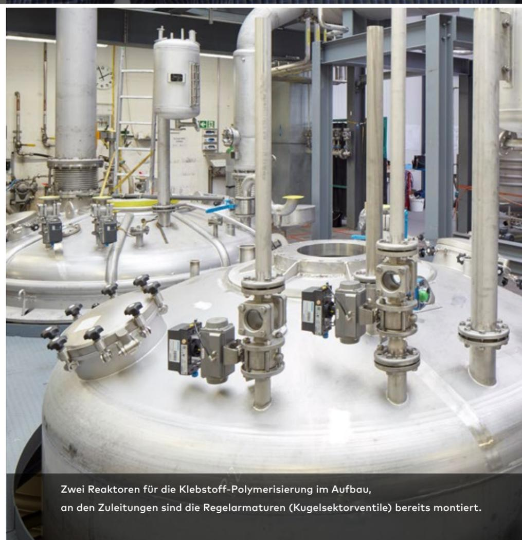
Zwei Reaktoren für die Klebstoff-Polymerisierung im Aufbau, an den Zuleitungen sind die Regelarmaturen (Kugelsektorventile) bereits montiert.
