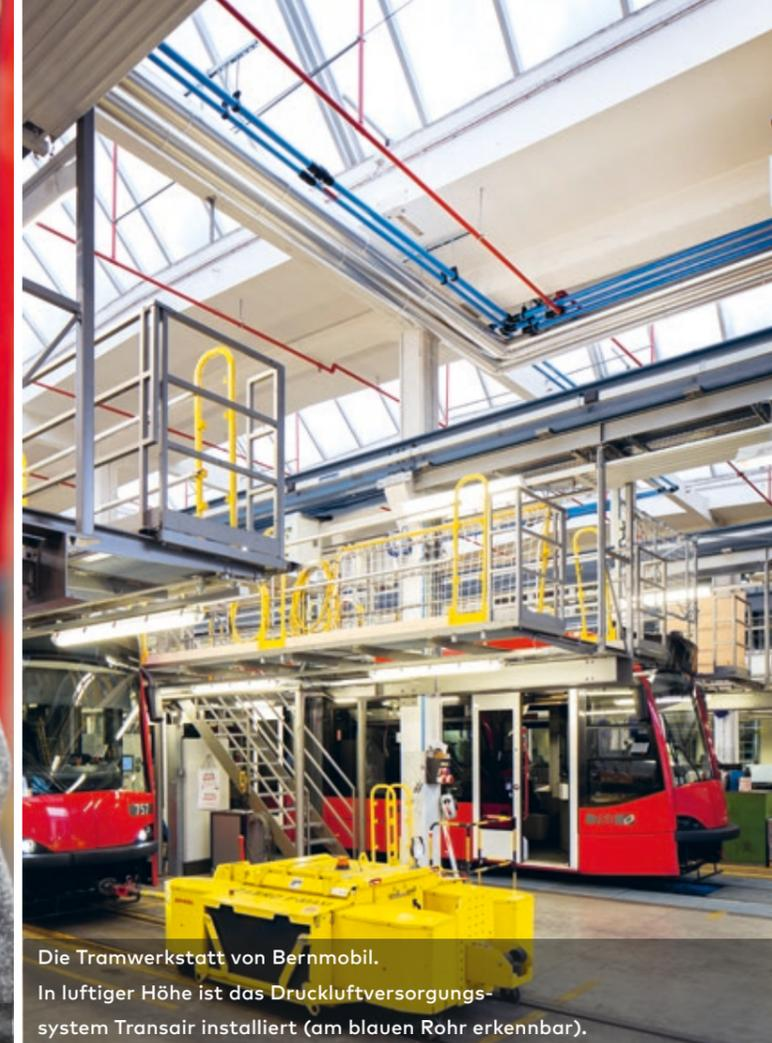
Die Tramwerkstatt von Bernmobil. In luftiger Höhe ist das Druckluftversorgungssystem Transair installiert (am blauen Rohr erkennbar).
