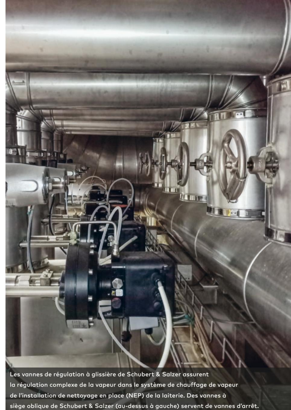
Les vannes de régulation à glissière de Schubert & Salzer assurent la régulation complexe de la vapeur dans le système de chauffage de vapeur de l'installation de nettoyage en place (NEP) de la laiterie. Des vannes à siège oblique de Schubert & Salzer (au-dessus à gauche) servent de vannes d'arrêt.
