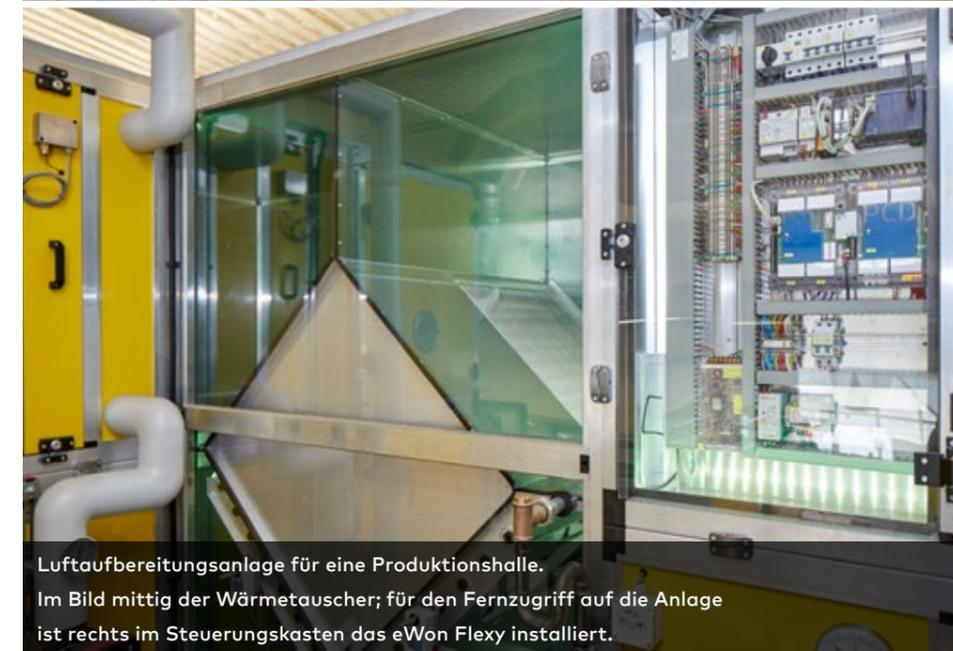
Luftaufbereitungsanlage für eine Produktionshalle. Im Bild mittig der Wärmetauscher; für den Fernzugriff auf die Anlage ist rechts im Steuerungskasten das eWON Flexy installiert.
