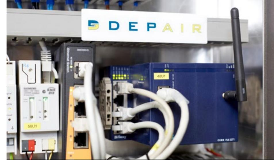
Das eWON Flexy, an der Antenne erkennbar, eingebaut in der Steuerung.
