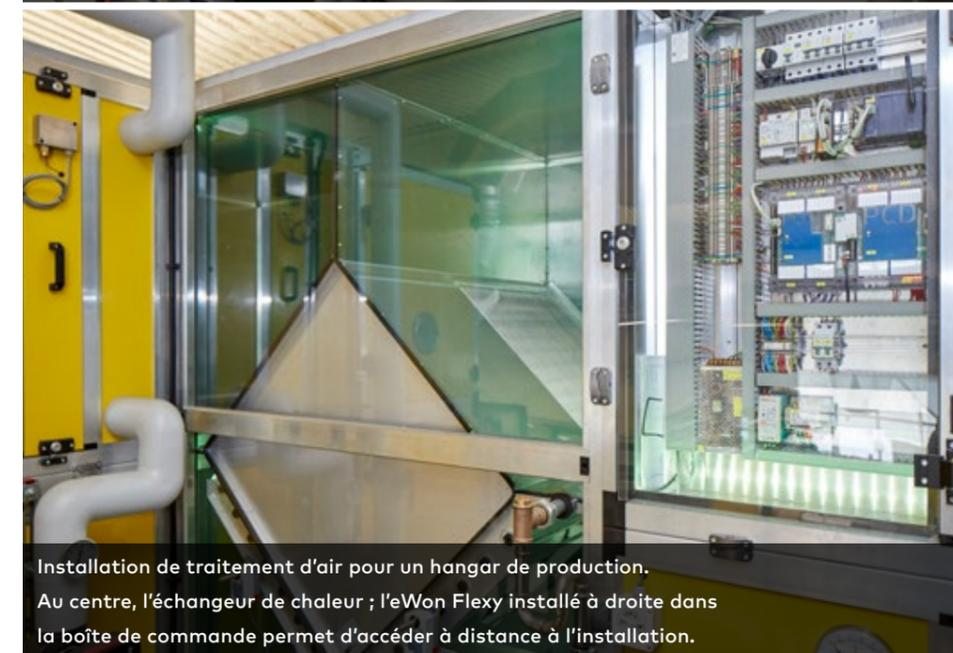
Installation de traitement d'air pour un hangar de production. Au centre, l'échangeur de chaleur ; l'eWON Flexy installé à droite dans la boîte de commande permet d'accéder à distance à l'installation.
