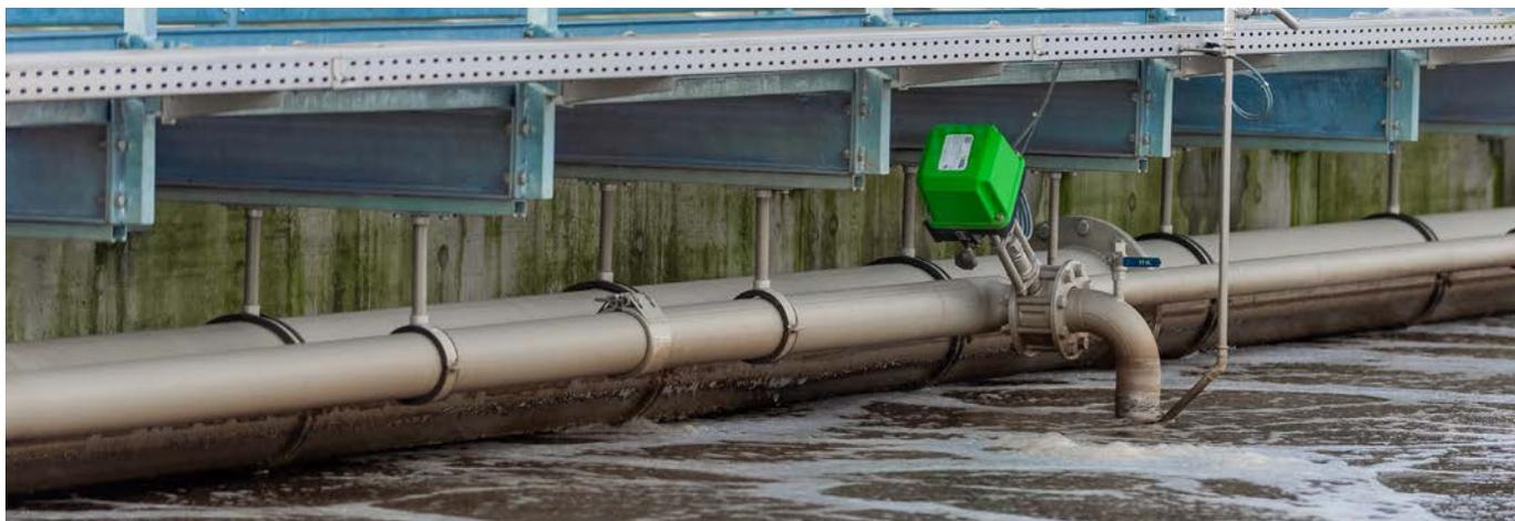
*Die präzise Sauerstoffgehaltregelung in den Biologiestrassen erfolgt durch das Gleitschieberventil.*
